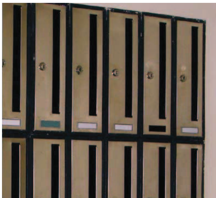
Detalle de instalación.
